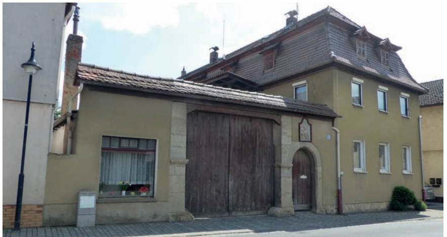
Mittlerer Gebäudezustand: Altbau mit Modernisierungsbedarf
