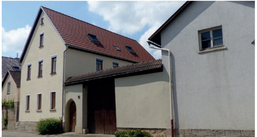
Guter Gebäudezustand: Sanierter Altbau in der Hauptstraße
