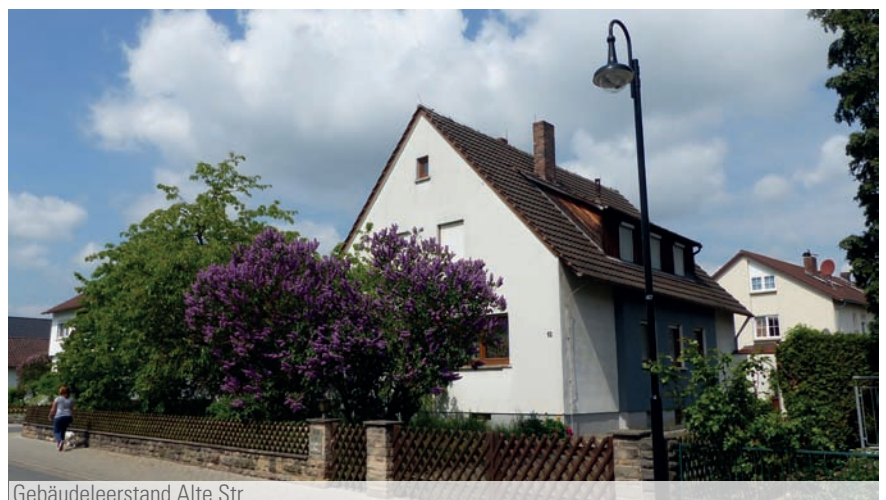
Gebäudeleerstand Alte Str.
